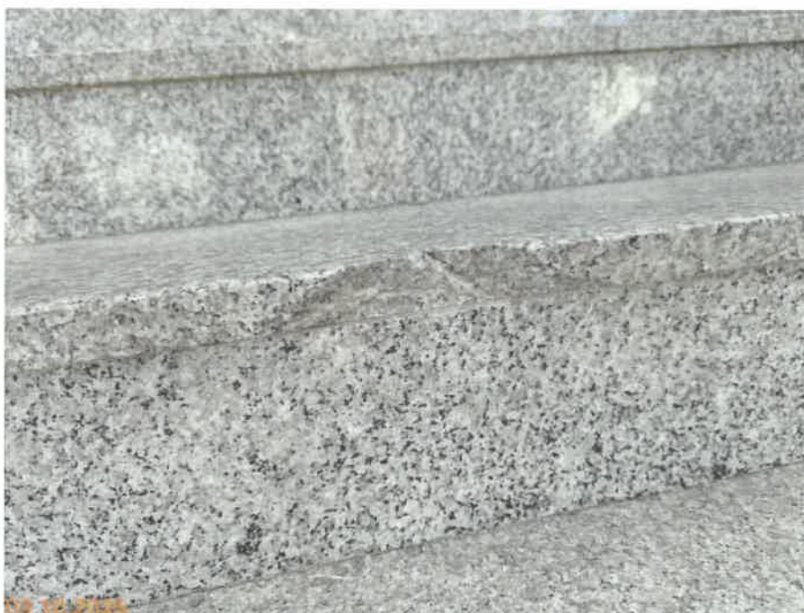
Zdjęcie nr 06_Widok na uszczerbienie stopnia piątego [licząc od góry] na schodach prowadzących na peron nr 2
