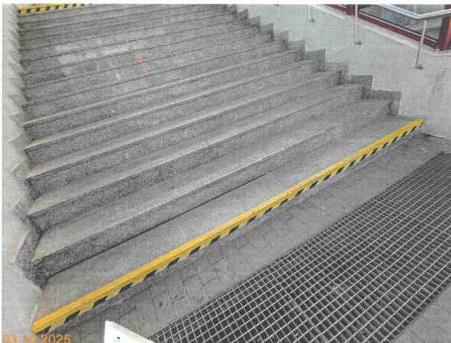
Zdjęcie nr 04_ Widok na osiadający ostatni stopień schodów na peron nr 2.
